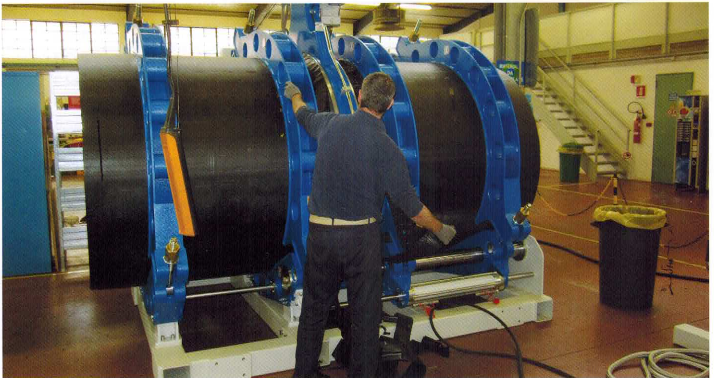
Рис. 6. Сварка трубы с толщиной стенки 95
